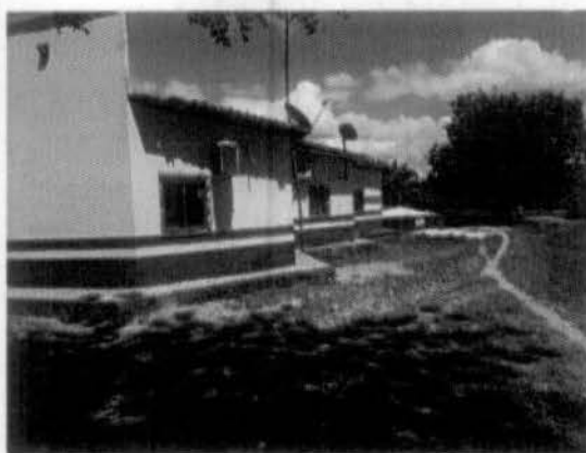
Imagem 2 – Fachada lateral e pintura externa
