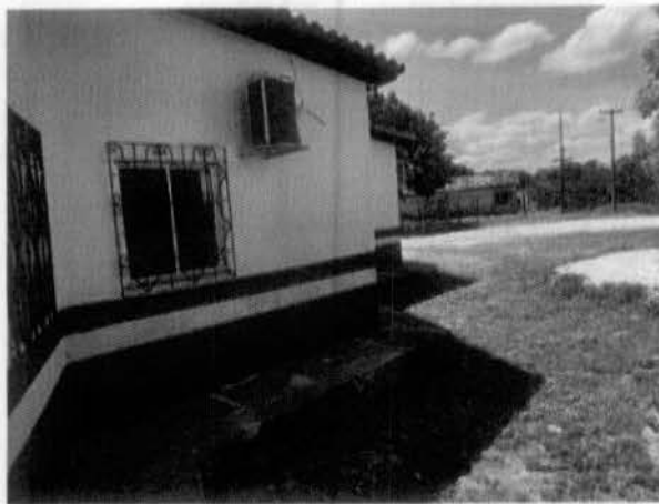
Imagem 3 – Fachada lateral e pintura externa
